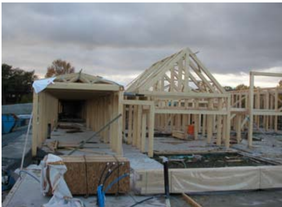
Takbjelkene er på plass over kapittelsalen. Til venstre ser vi kontorfløyen.
