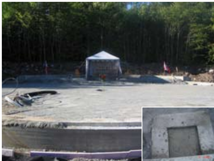
Den nye St. Frans kirkes grunnmur og grunnsten.
